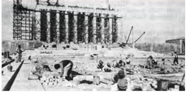
Anıtkabir inşaatından görünüm, Ankara
