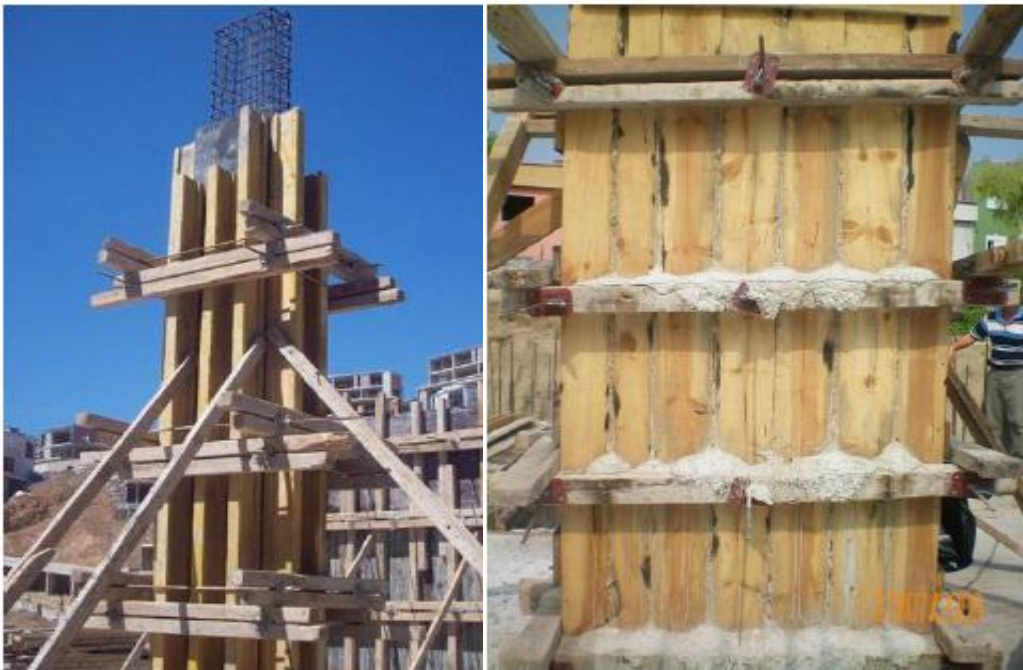
Resim 1: Kolon Kalıpları
