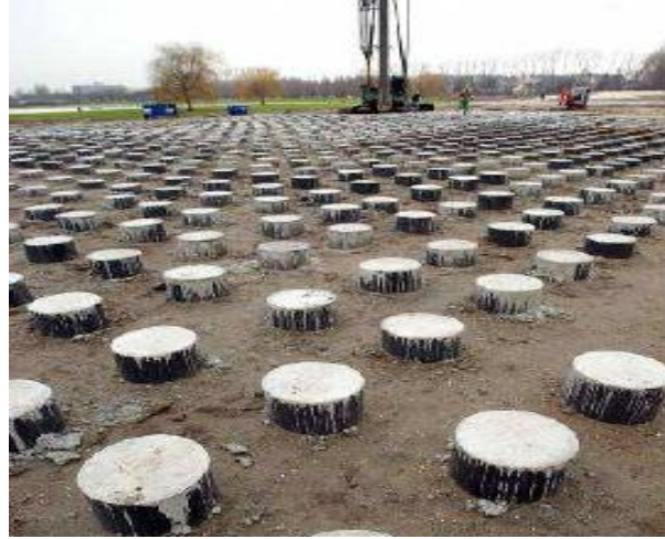
Resim 15: Kazıklı Temel Üst Görünüş
