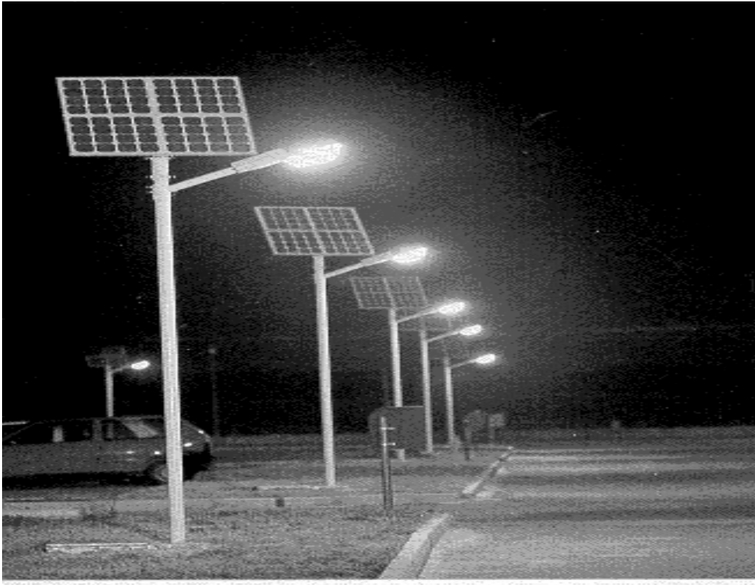
Şekil 4.7. Güneş Pilleri ile Sokak Aydınlatması [15]
