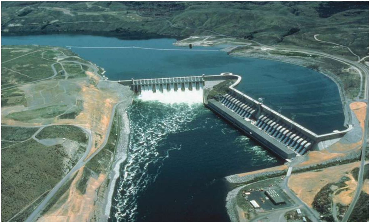
Resim 7.17: Elektrik üretimi yapan bir hidroelektrik santrali
